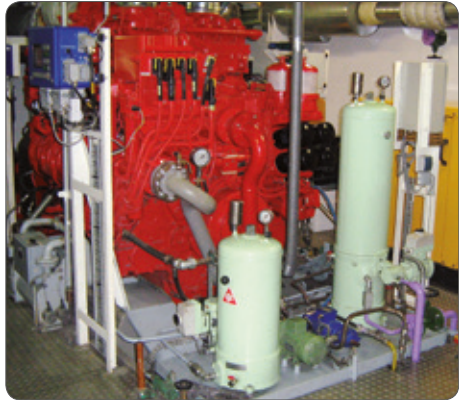
Motore MTU con filtro di filtrazione fine installato (a sinistra) per l'olio di lubrificazione e filtro separatore CJC per la filtrazione del diesel (destra)
