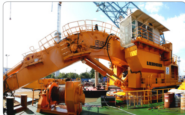
Liebherr-Pontonbagger P 995 Litronic auf Stelzenponten MP40 - im Einsatz beim Bau des Container-Tiefwasserhafens in Wilhelmshaven.
